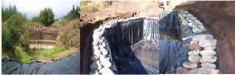
Foto 5. Instalación de la geo-membrana impermeable. Fotos 6 y 7: se instalan canales de drenaje en el borde y en el fondo.
