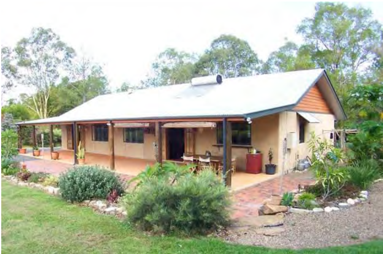
Casa de barro construida con la técnica de tapial. Nótese el panel solar en el techo y el calentador solar de agua. Crédito: Rammed Earth Constructions Pty Ltd, 90 Mountain View Road, Maleny Qld 4552 Australia.
