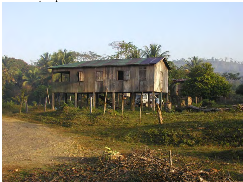
Uno de los hoteles más extraños en que me haya alojado fue en Sahsa; el peligro es en la puerta al lado derecho del edificio.
