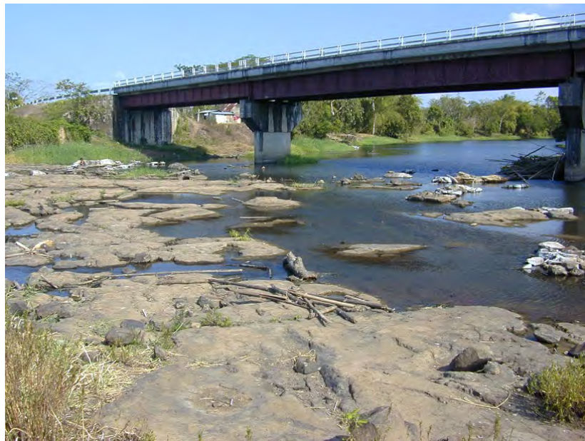
El puente cruzando el Río Rama, viendo río arriba hacia la parte tranquila del río; río abajo los rabiones hacen el acceso muy difícil.
