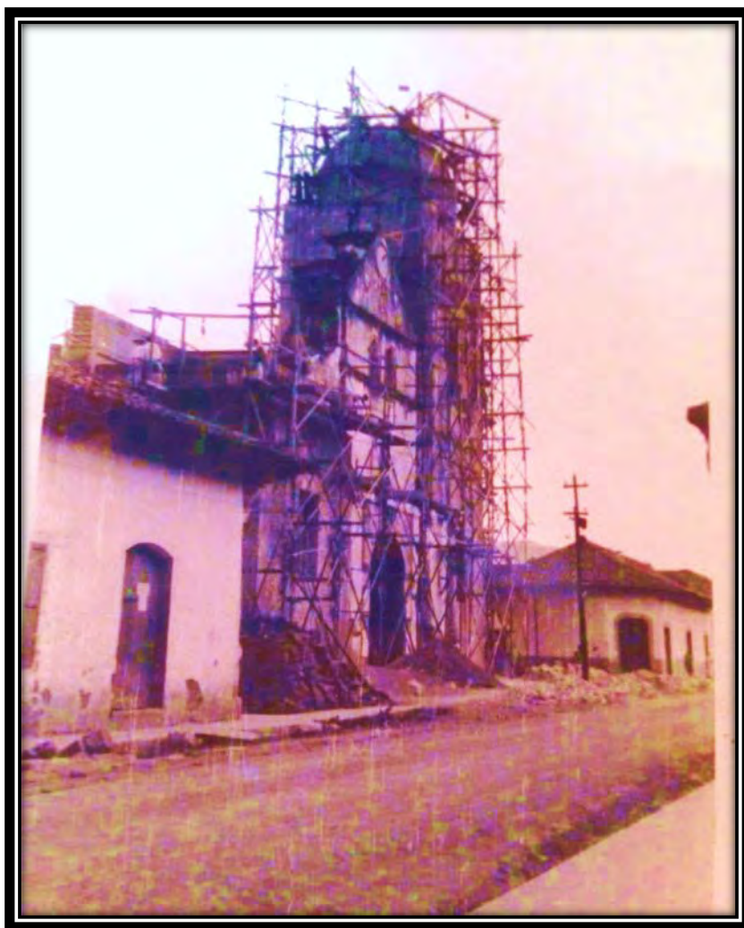
Edificación de las torres de la Iglesia Sn Juan.
