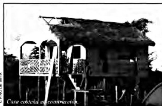
Casa costeña en construcción
