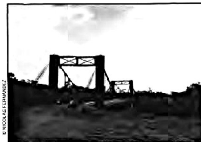
Puente de Sinsin, Puerto Cabezas
